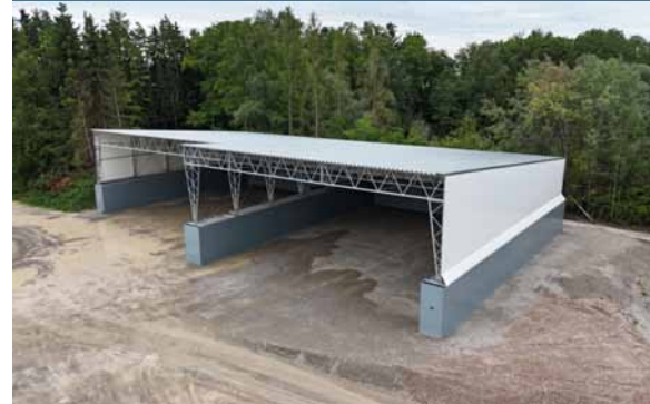
Pulthallen mit Trapezblechverkleidung
