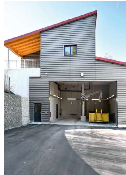
Zweistöckiges Entwässerungsgebäude der Kläranlage Parsberg mit Abholbereich der Container
